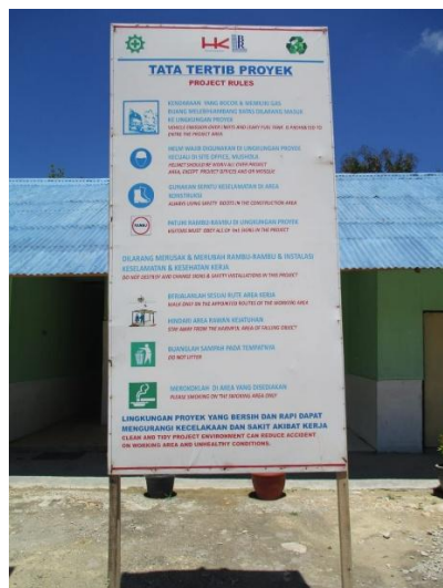
Gambar 6 Papan Rules Pembangunan Jembatan Petuk
